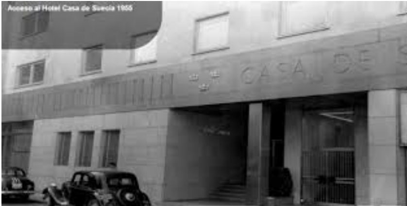
Foto.- Fachada del Hotel en su estado original
